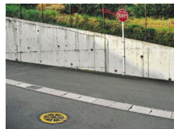
地下に埋設された防火水槽の例
